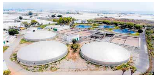
Depuradora de El Bobar. R. I.
